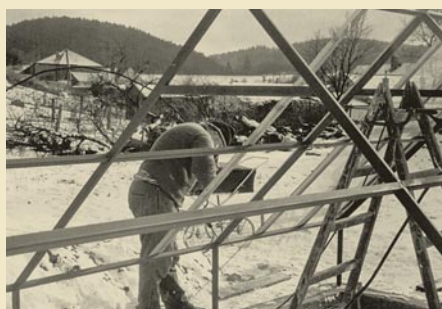
Prosinec 1977 – stavba prvního skleníku
